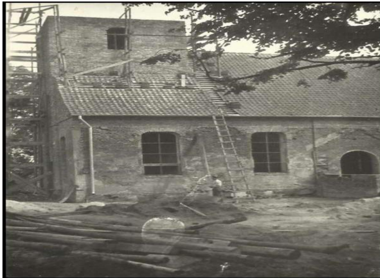
Rohbau - Bau des Kirchturms (Foto Internet)
