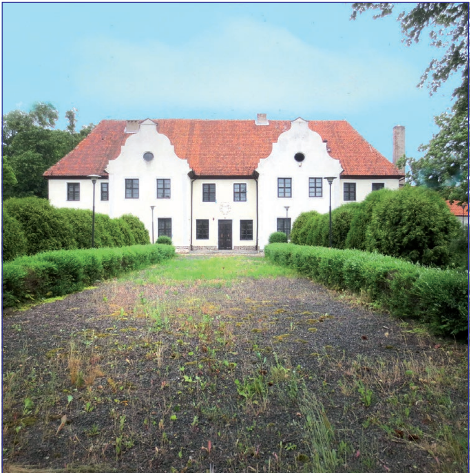
Das ehemalige Gutshaus der Familie v. Tettau in Tolks
