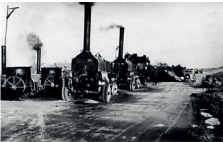
Bau der Reichsautobahn mit Loren auf Schienen, Bild Fa. Michel
