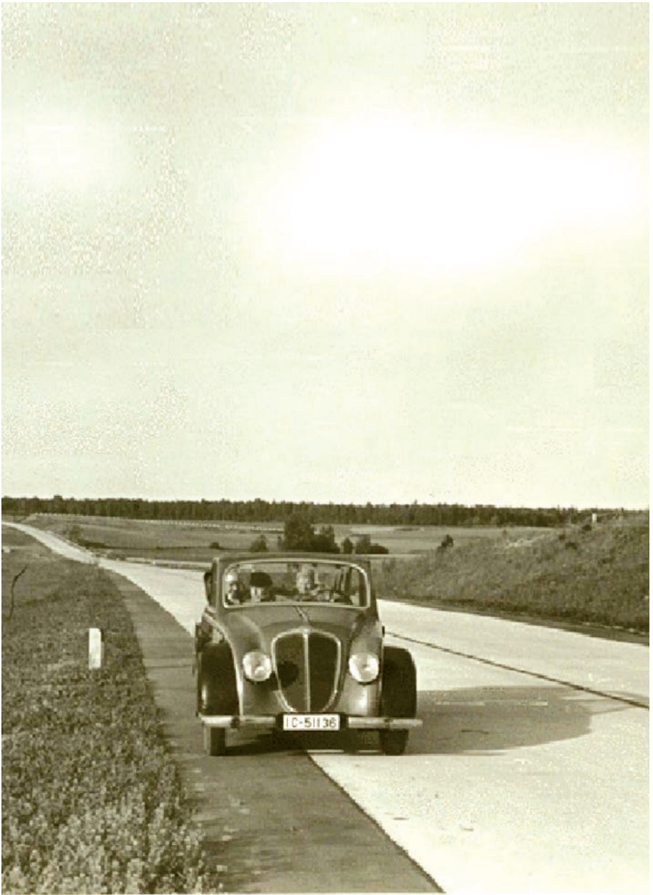
Reichsautobahn. RAB Königsberg-Elbing, bei Groß Rautenberg. Der Autobahnabschnitt Schalmey - Neu Münsterberg wurde Ende September 1937 dem Verkehr übergeben.
