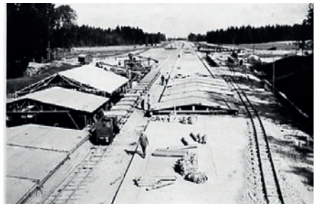
Bau der Reichsautobahn mit Loren auf Schienen, Bild Fa. Michel
