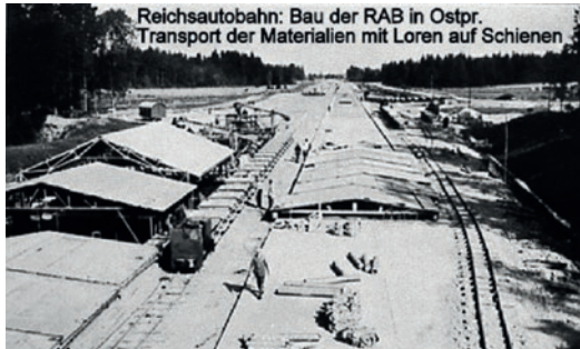
Bau der Reichsautobahn mit Loren auf Schienen, Bild Fa. Michel
