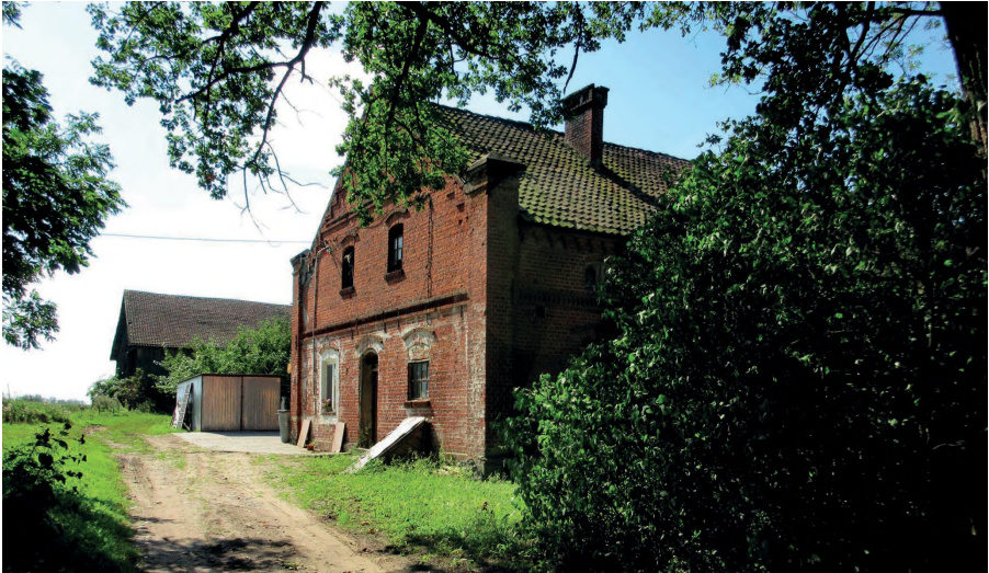
Augam, Stallgebäude Hof Grube aus nördl. Richtung, Foto: G. Birth
