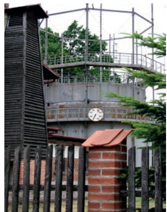
Gaswerk in Landsberg (1908 errichtet – bis 1992 in Betrieb)
