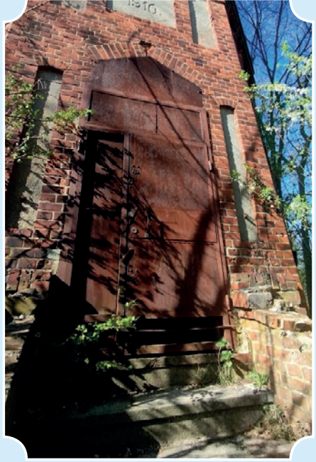
Geschlossener Eingang zum Wasserturm
