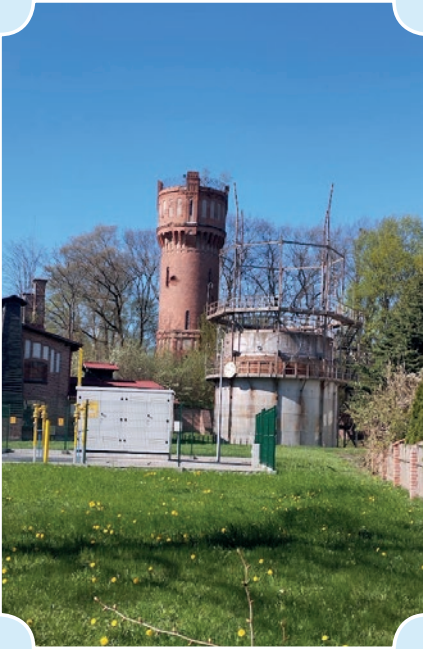
Blick auf das alte Gaswerk und den Wasserturm
