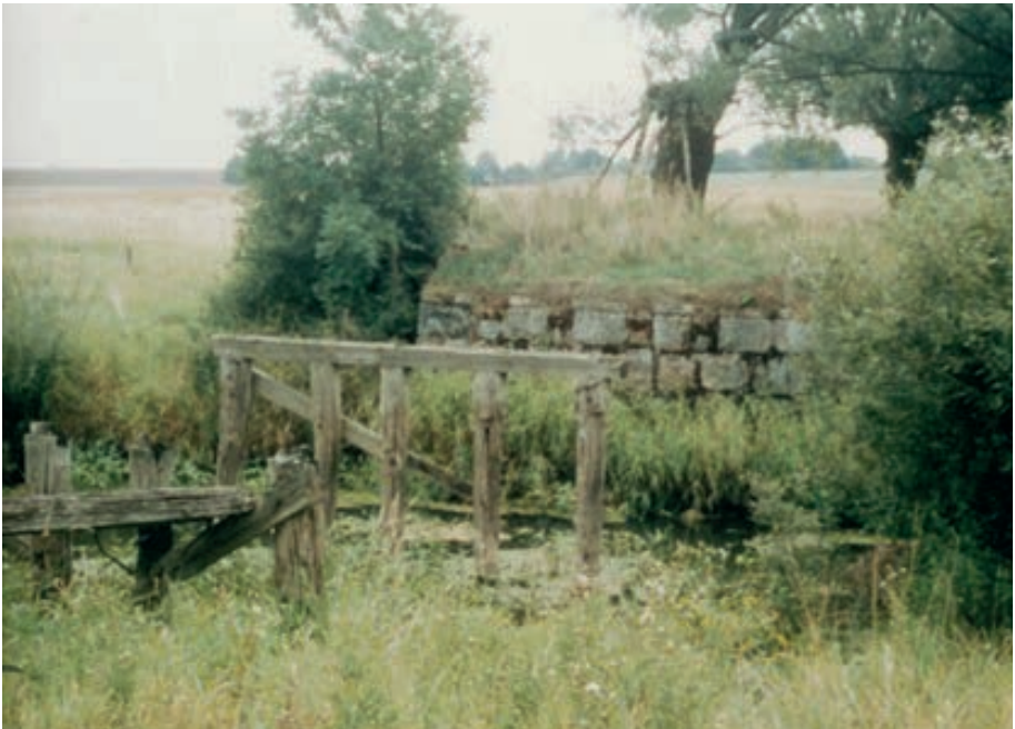
Reste der Frischingbrücke zwischen Moddien und Wöterkeim, Aufnahme 1992, Bildarchiv
