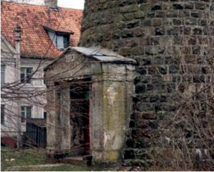
Eingang zum Wasserturm, Aufnahme von 1998, Bildarchiv
